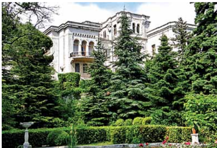
Pałac Jusupowa w Koreizie (Wielka Jałta), który podczas konferencji był rezydencją Stalina. To właśnie tam 8 lutego odbyła się uczta na cześć Brytyjczyków i Amerykanów
