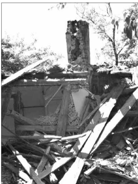
Зруйнований будинок М. Рильського
