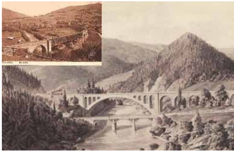
Wiadukty kolejowe nad Prutem
